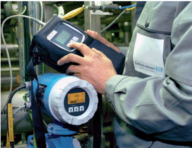
Obr. 5 Verifikácia prietokomera in-situ pomocou simulačného prístroja – prietokomer netreba z potrubia demontovať
