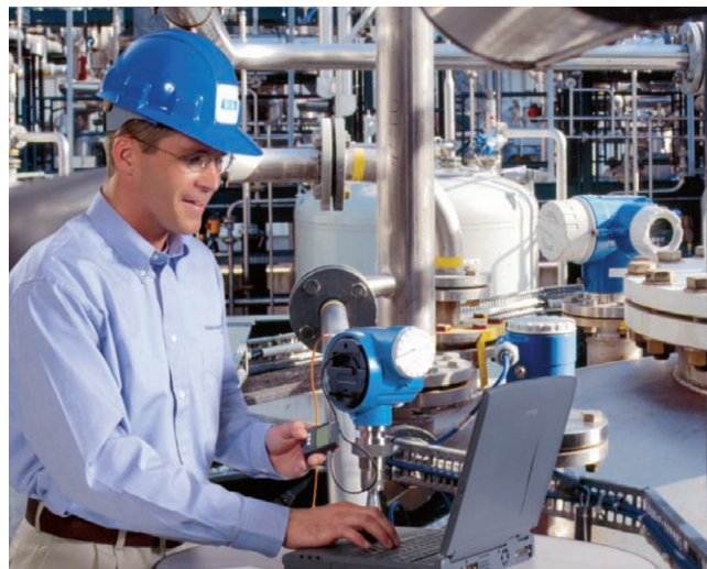
Obr. 2 Údaje z kalibrácie sú pracovníkom prístupné prostredníctvom vhodného softvéru, ako je napr. CompuCal od Endress+Hauser
