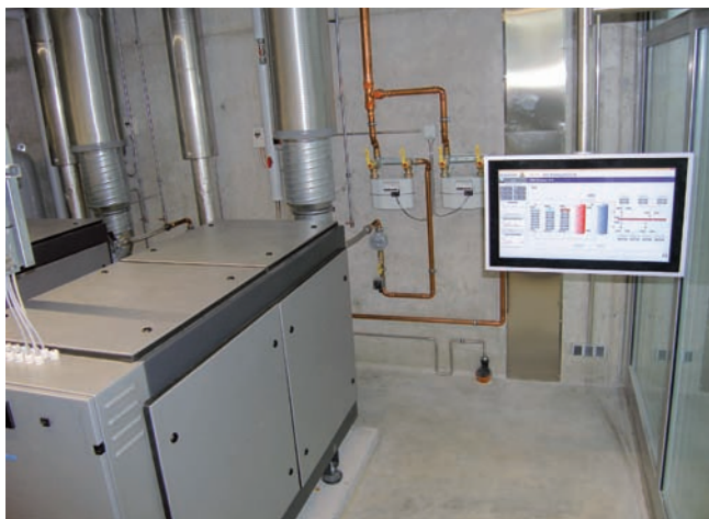
V hlavnej kontrolnej miestnosti slúži ako ovládacie rozhranie pre Energiefabrik ovládací 18,5" panel AP900.
