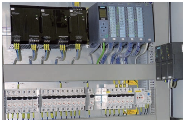
Riadenie a sieťové prepojenie jednotlivých liniek zabezpečujú výkonné PLC.
