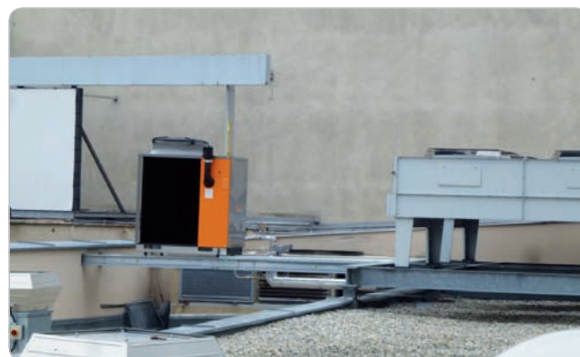
Obr. 1 Instalace tepelného čerpadla na hotelu International v Brně
