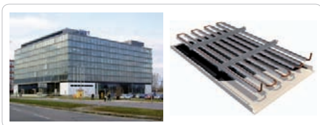
Obr. 1 Budova A. Vľavo pohľad na budovu, vpravo je zavesený podhlád so systémom NTV/VTCH
