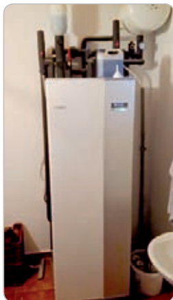
Obr. 1 Tepelné čerpadlo inštalované v dome
