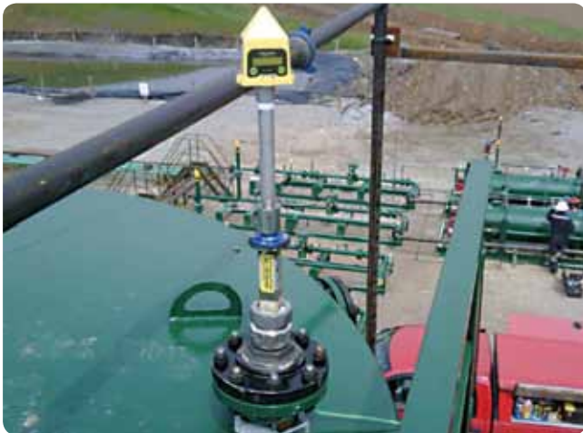
Obr. 1 Příklad instalace bezdrátového snímače Accutech
