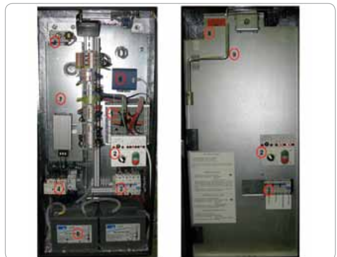
Obr. 4 Skriňa diaľkového ovládania – bez medzisteny a s medzistenou
