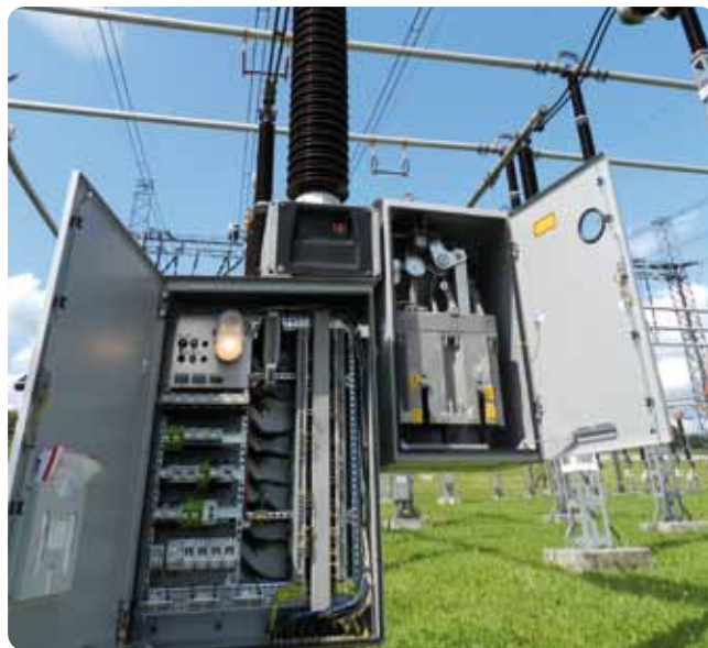
Obr. 6 Skriňa ovládania vypínača 3APF1, vpravo pohon vypínača
