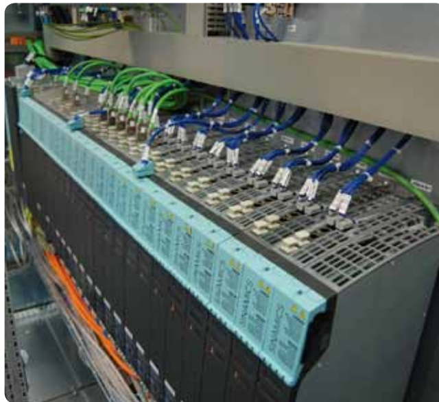
Obr. 2 Hlavný rozvádzač s pohonmi SINAMICS
