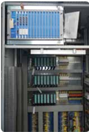
Obr. 7 Systém na meranie vibrácií Bentley Nevada 3500 (v hornej časti rozvádzača) a PLC parnej turbíny
