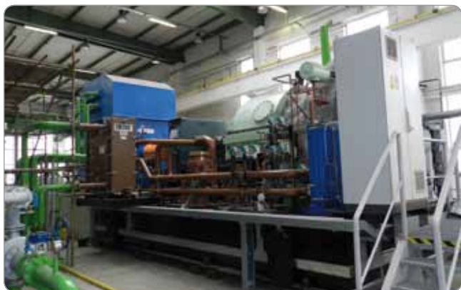
Obr. 2 Odberovo-kondenzačná parná turbína
