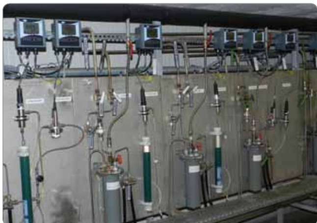
Obr. 3 Vzorkovače parametrov napájacej vody, kondenzátu, odluhov VT, NT a pary VT a NT
