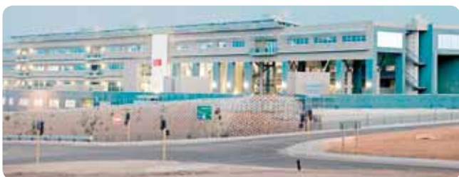
Obr. 1.: Areál energeticky efektívnych budov ABB v Južnej Afrike
