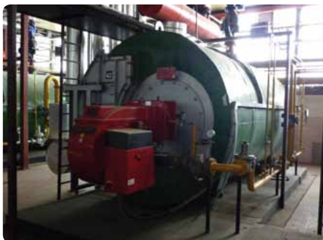
Obr. Plynový kotol v kotolni sídliska Juh
