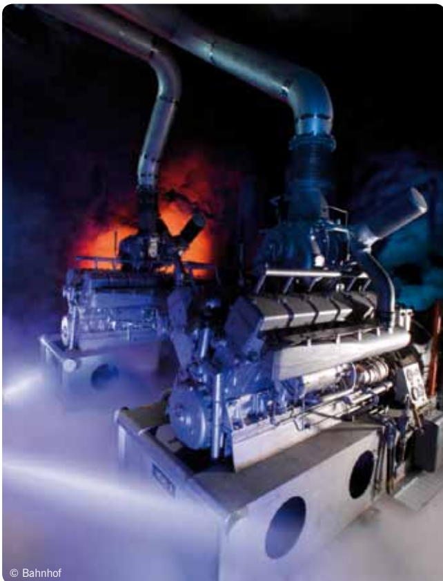
Obr. 3 Dieselagregáty pôvodne skonštruované pre ponorky
