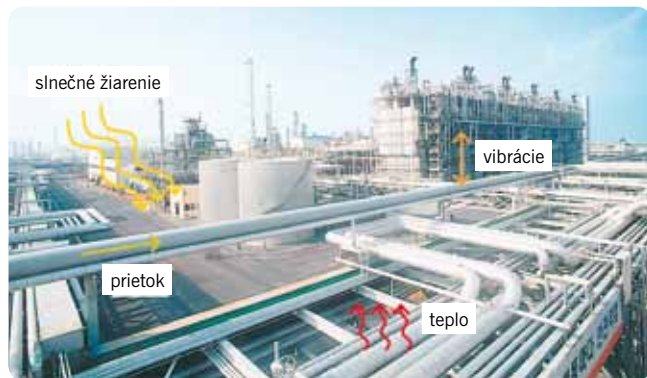
Obr. 2 Zber energie umožňuje premenu energie vytvorenej priemyselnými procesmi na elektrickú energiu
