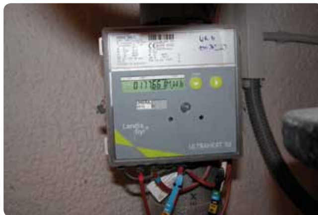
Obr. 5 Merače odovzdanej energie UltraHeat od spoločnosti Landis + Gyr
