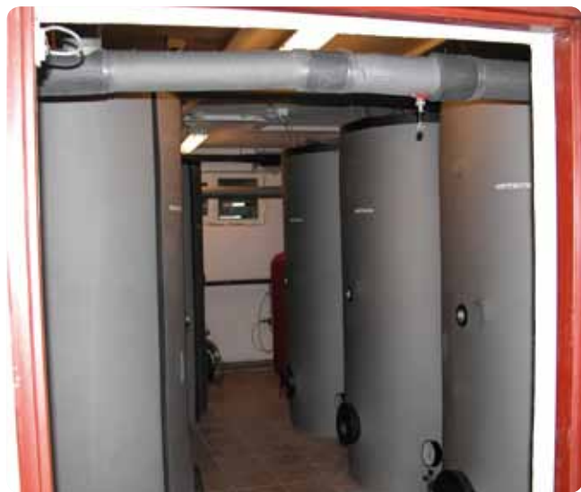
Obr. 4 Šesť zásobníkov s teplou vodou
