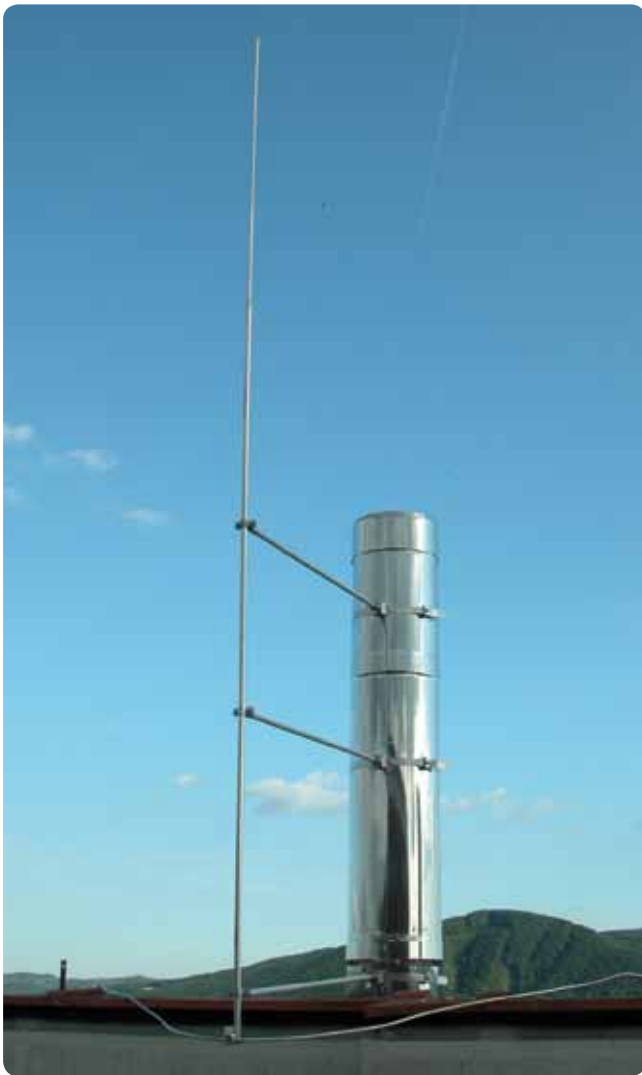
Obr. 3 Zachytávacia tyč umiestnená na antikorovom komíne
