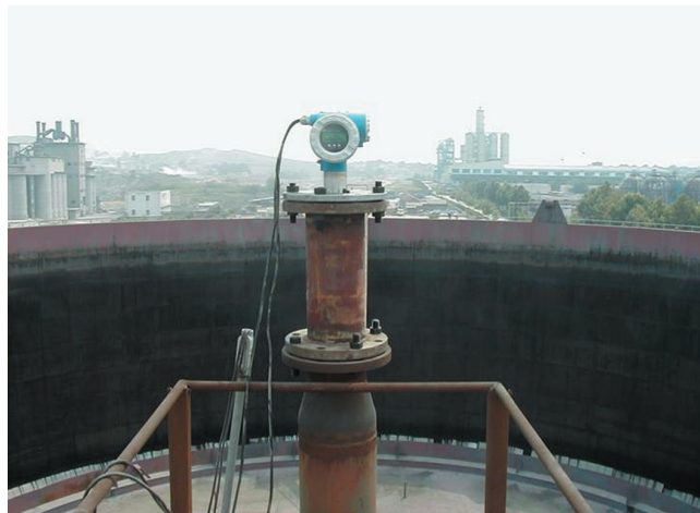
Obr.8 Micropilot S v meracej trubke na veľkoobjemovom zásobníku s plávajúcou strechou na ropu v rafinérii Jinan v Číne
