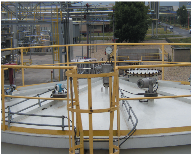
Obr.6 Micropilot M v petrochemickej výrobe na Slovensku
