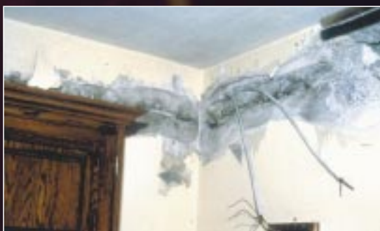
Dynamické účinky bleskového prúdu pri prechode elektroinštaláciou rodinného domu
