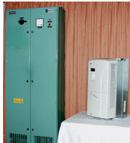
Obr.6 Na ľavej strane je menič zo 70. rokov pre 15kW motor a na pravej strane je nový ABB menič pre 70kW motor
