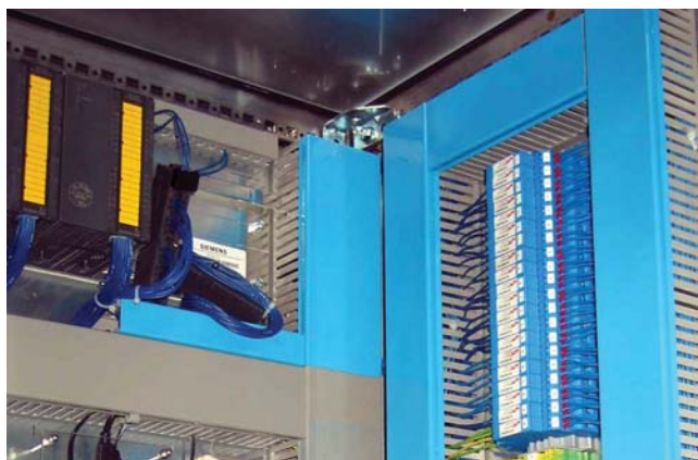
Obr.2 BLITZDUCTOR® CT, energeticky koordinované zariadenie SPD pri ochrane procesného riadenia
