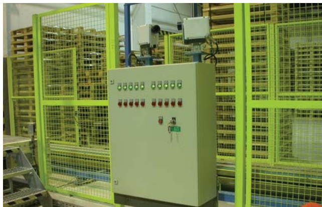
Obr.4 Termokamery č. 4 a 9 a skrini PLC protipožiarneho systému
