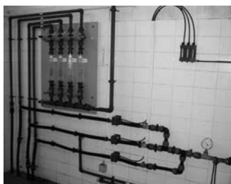
Riadenie prietokového množstva v chlórovní ÚV
