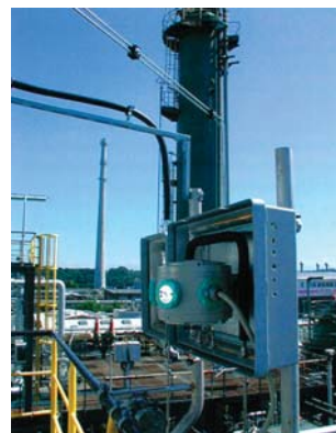
Meranie kyslíka a etylénu priamo na etyléndichloridovom reaktore procesným plynovým chromatografom
