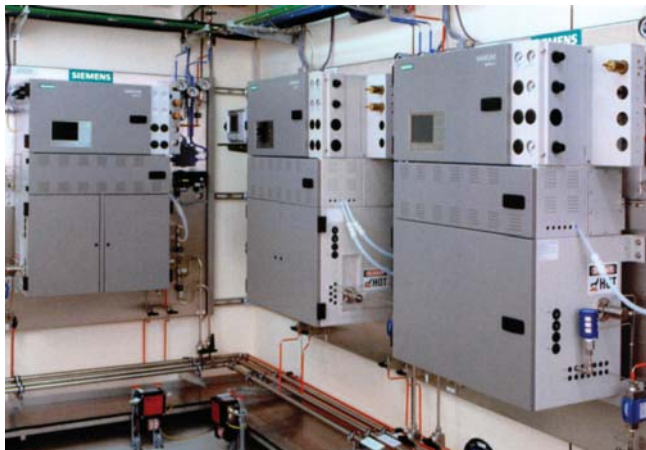
Procesné plynové chromatografy v analyzátorovom domci zariadenia na výrobu aromatických uhľovodíkov
