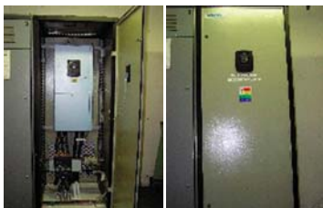
Osadenie nového FM VACON do existujúcej skrine pôvodného FM dymového ventilátora kotla č. 2
