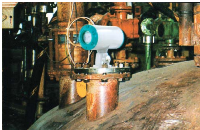
Meranie výšky hladiny farieb – použitie bezdotykového radarového prístroja SITRANS LR 300
