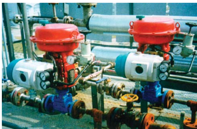
Regulátor polohy ventilu SIPART PS2 v Ex- vyhotovení v chemickom zariadení
