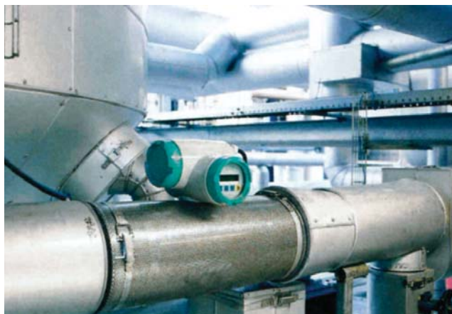
Ultrazvukový prietokomer SITRANS F US v zariadení na výrobu formaldehydu
