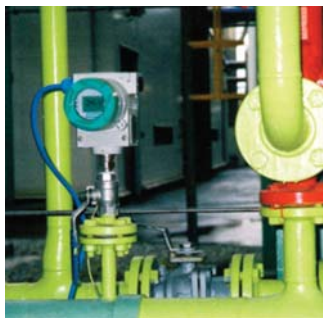
Meranie absolútneho tlaku prístrojom SITRANS P v prečerpávacej stanici toluénu
