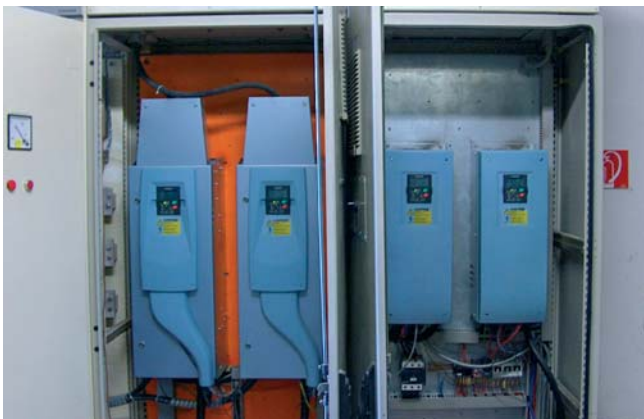
Frekvenčné meniče navíjačky (vľavo) a odvíjačky (vpravo)
