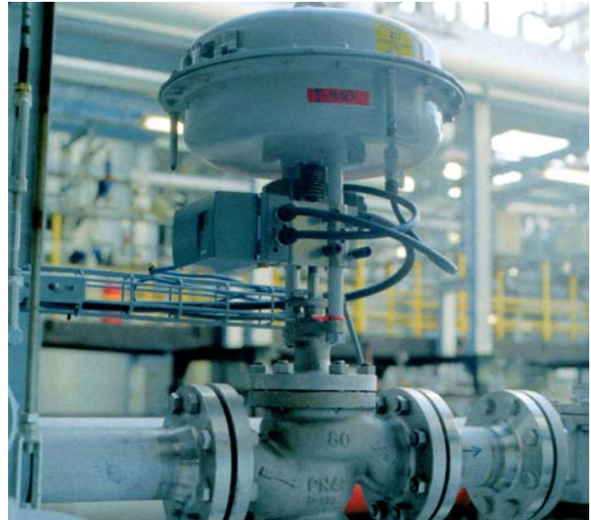
SIPART PS2: Najčastejšie používaný inteligentný regulátor polohy pre posuvné a výkyvné pohony
