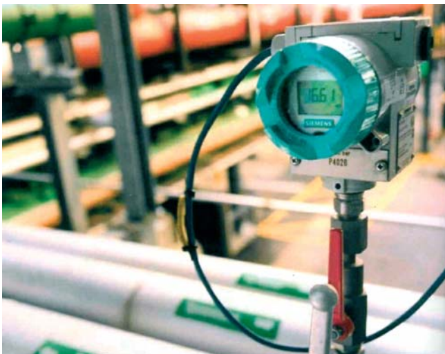
Zaručená bezpečnosť! SITRANS P DS III – možnosť použitia pre SIL 2, s redundanciou aj pre SIL 3
