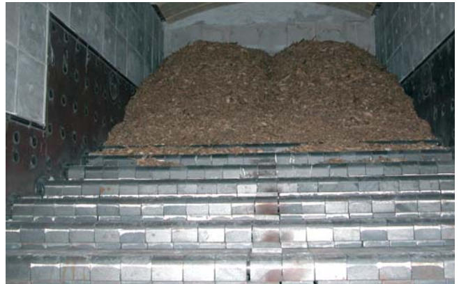
Stupňovitý pohyblivý rošt, na ktorom prebieha spaľovanie drevoštiepkov v kotle
