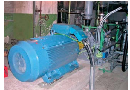
Pohon zrekonštruovaného čerpadla v Žilinskej teplárenskej
