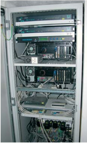
Skriňa komunikačných serverov, konvertory Moxa v hornej časti
