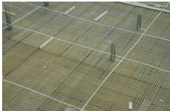
Obr.8 Interný plochý zemnič, realizovaný armovaním podlahových platničiek, ktorý je pospájaný žiarovo zinkovanou páskovou oceľou (v sieti 5 x 5 m)
