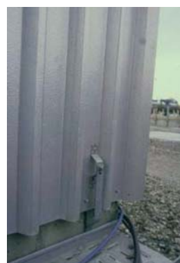
Obr.9 Pripojenie prepojených kovových fasád na uzemňovaciu sústavu
