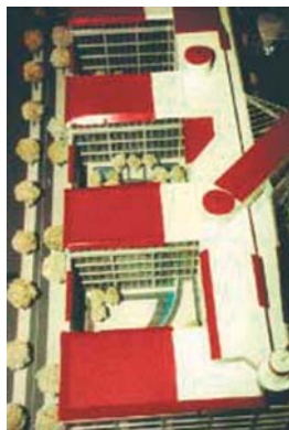
Obr.5 Umiestnenie zachytávacích vedení s pomocou metódy bleskovej gule (označených plôch sa blesková guľa dotýka)
