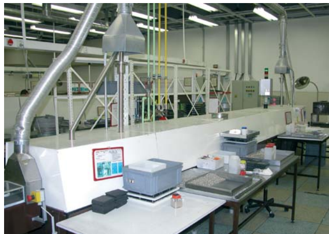
Zrekonštruovaná priebežná spájkovacia pec BTU
