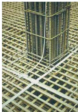
Obr.15 Armovanie podlahy spojené s armovaním podpory pomocou vedení a svoriek
