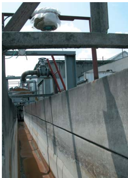
Ultrazvukové meranie výšky hladiny v plaviacom žľabe repy
