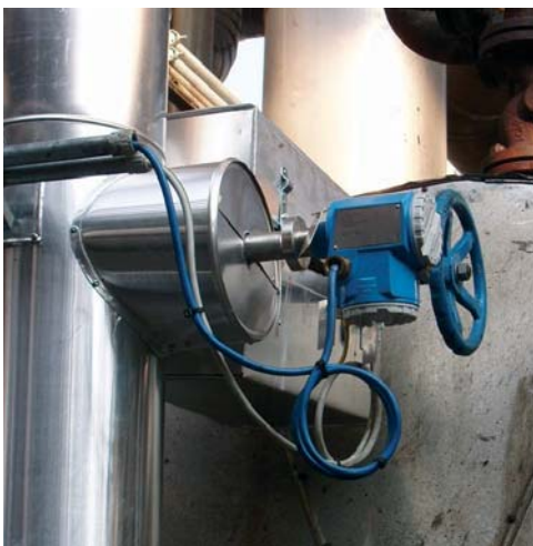
Obr.6 Vysokoteplotný vibračný spínač Liquiphant pre teplotu do +280 °C inštalovaný u slovenského zákazníka v prostredí SNV
