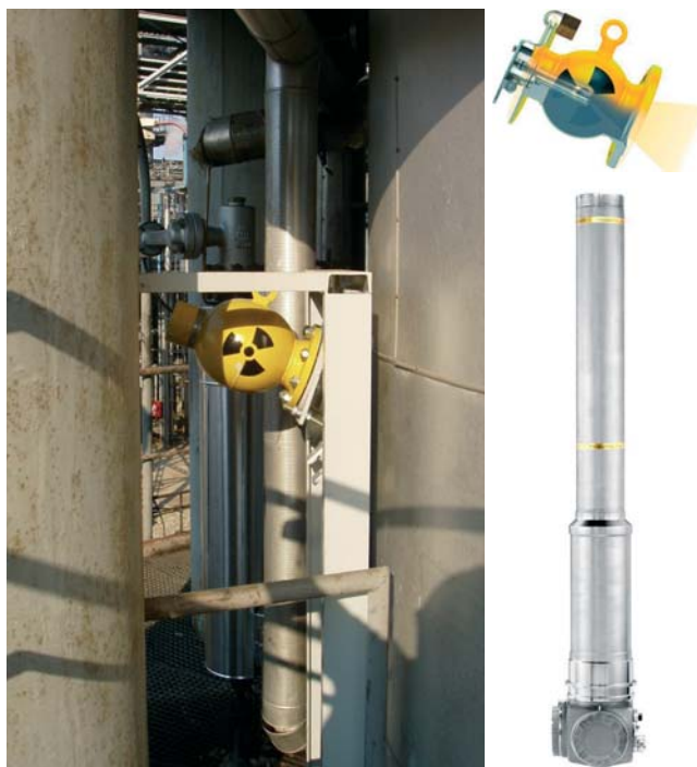
Obr.4 Kontinuálne rádiometrické meranie výšky hladiny inštalované na Slovensku
