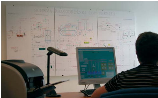
Miestnosť dispečingu s riadiacim počítačom s nainštalovaným SCADA systémom D2000
