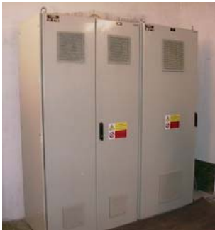
Obr.3 Riešenie regulácie ventilátorov s FM VQFREM 400 V – 132 kW a VQFREM 400 V – 75 kW a VQFREM 400 V – 75 kW v rozvádzačovom vyhotovení
