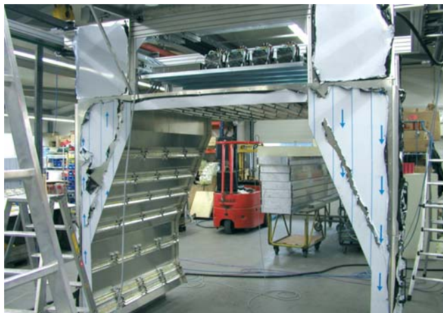
Montáž vypaľovacieho portálu
