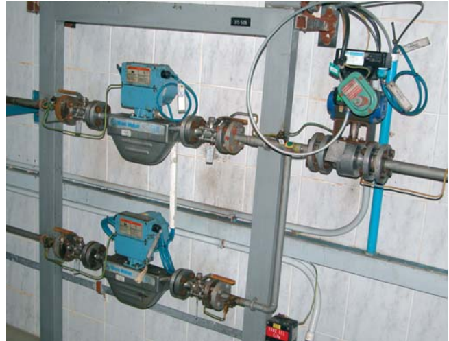
Meranie prietoku a diaľkovo ovládaná armatúra
