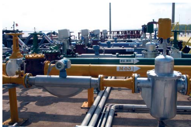
Obr.6 Skupina prietokomeroch Promass F na stáčacej linke ropných produktov do námorných tankerov
