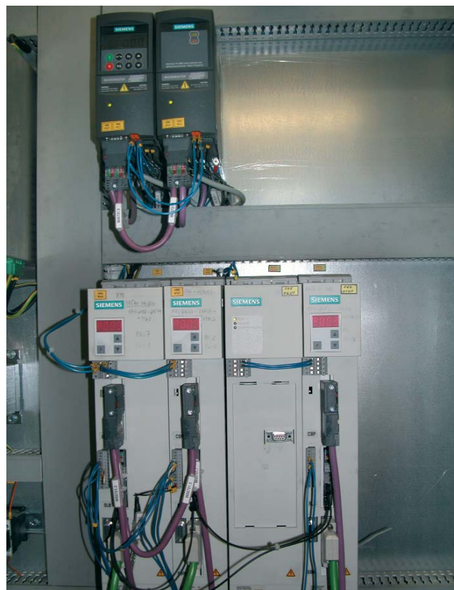
Rozvádzač linky: meniče frekvencie Micromaster (hore), meniče frekvencie Masterdrives Motion Control (dole)
