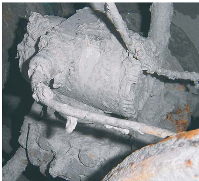
Obr.1 Diferenčný tlakový vysielač v náročnom prostredí: prístup k údržbe prístroja je sťažený
