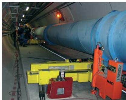
Obr.11 Prebratie kryomagnetu na TM
