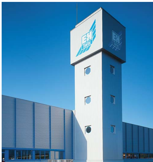
Preparovacia nádrž kalibračnej trate Endress + Hauser Flowtec
