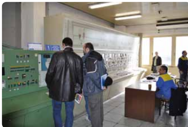
Pôvodný technologický panel pred modernizáciou
