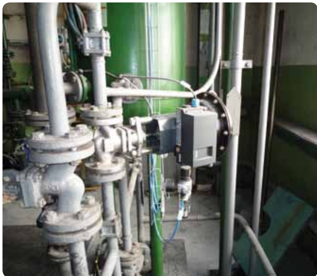
Pneumatický regulačný ventil s korektorom Siemens
