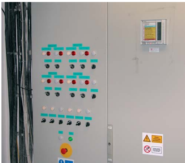
Rozvádzač s riadiacou stanicou Unigr PRU 10.64
