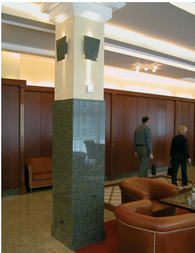
Snímanie priestorovej teploty (biele puzdro snímača na stĺpe)
