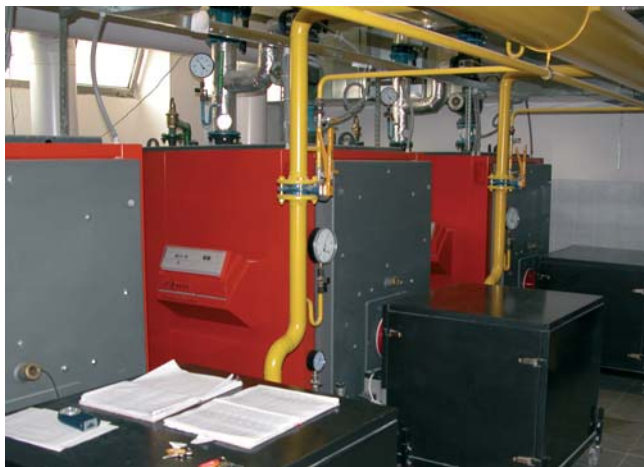
Technológia plynovej kotolne
