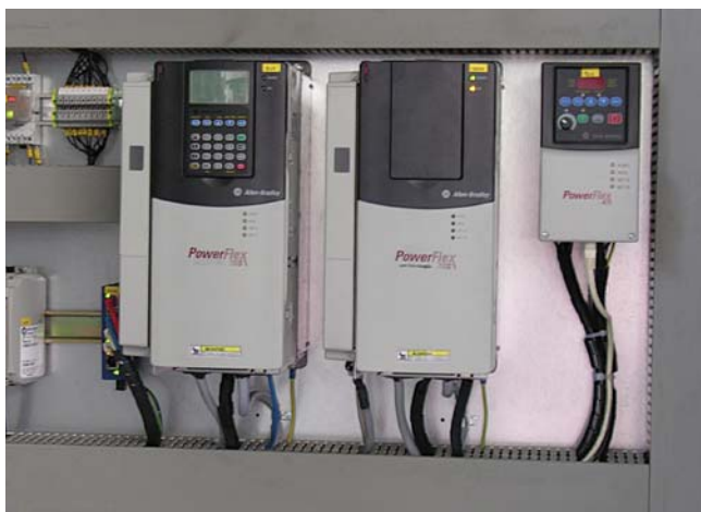
K automatizaci strojů zvolila společnost Acemal systém složený ze dvou pohonů Allen-Bradley Powerflex 700S, z nichž jeden funguje jako nadřazená a druhý jako podřízená jednotka
