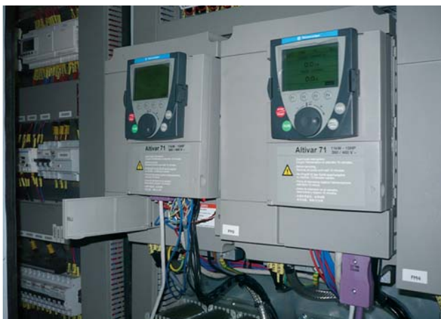
Frekvenčné meniče Altivar 71 na zdvih, prepojené CANopen zbernicou (ľavý s kartou Controller Inside)
