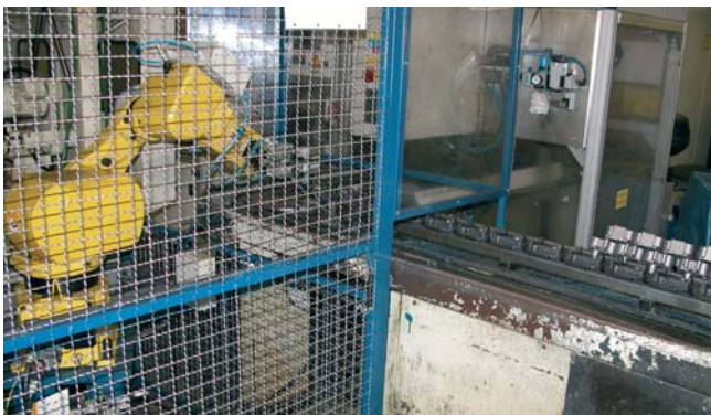
Robot čaká na príchod vozíka s obrobkom, pohľad z vonkajšej strany bezpečnostnej ohrady
