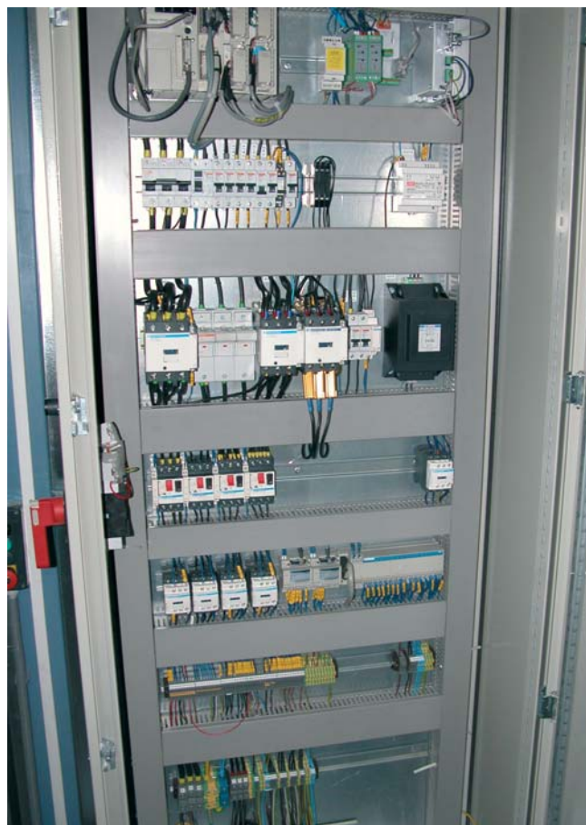
Obr.7 Rozvádzač technológie plazmového reaktora
