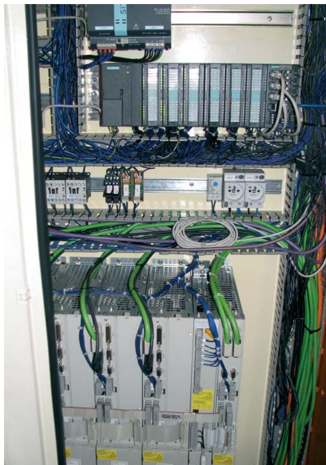
Celkový pohľad na rozvádzač po vykonaní výmeny pohonov a riadiaceho systému
