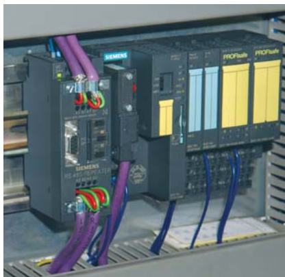
Základom modernizácie je chybovo bezpečná decentralizovaná periférna jednotka ET 200S, ktorú možno prostredníctvom komunikačného systému Profibus jednoducho prepojiť s riadiacim systémom stroja
