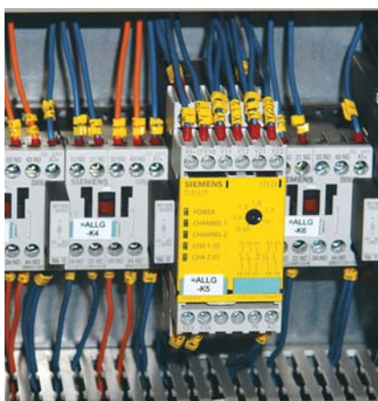
Bezpečnostné relé Sirius 3TK2845 integruje v jednom prístroji tri funkcie a tým šetrí priestor aj náklady na inštalovanie
