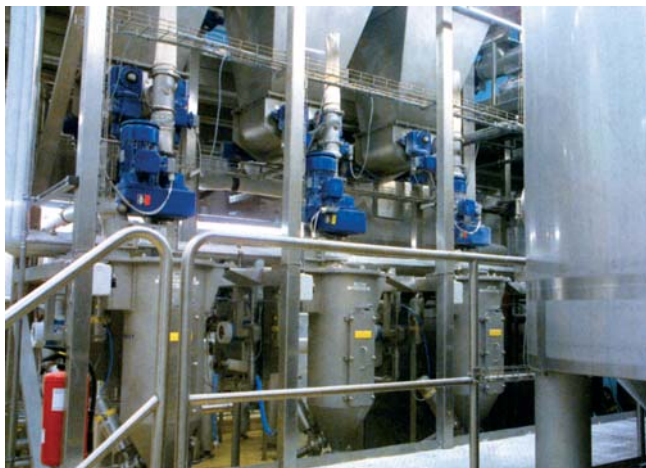
Obr.2 Jednotlivé prísady sú uložené v silách a prostredníctvom pohonov Nord sa premiestňujú do zariadení na miesenie cesta
